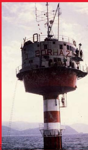
N'avez-vous jamais rêvé d'une bouée... habitable de 60 m<sup>2</sup> ? Proposée par le commandant Cousteau et lancée en mai 1963, la bouée Cousteau a permis de réaliser des observations jusqu'à 50 mètres de profondeur. Armée par deux hommes d'équipage, elle pouvait accueillir six chercheurs.
