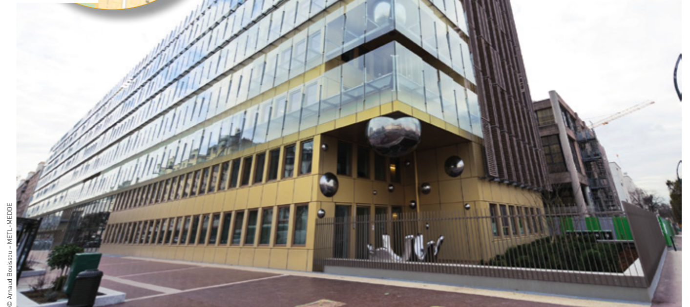
L'angle du bâtiment au croisement de la rue Pasteur et l'avenue de Paris.
