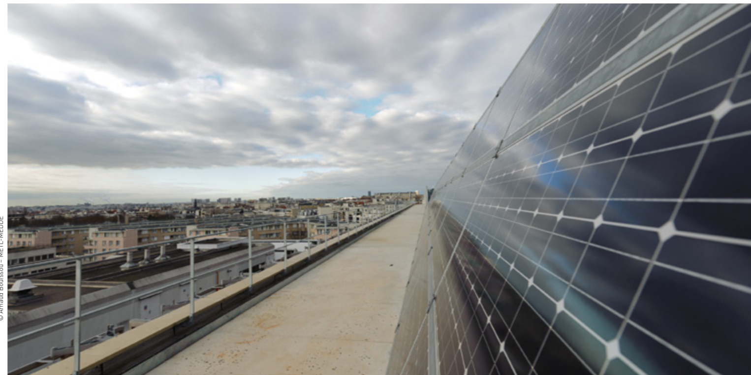
Les panneaux solaires sur le toit de l'immeuble.
